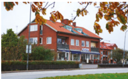
Fönsterbyte på Margrete-torpsvägen 11! På bilden är inte arbetet helt klart.
