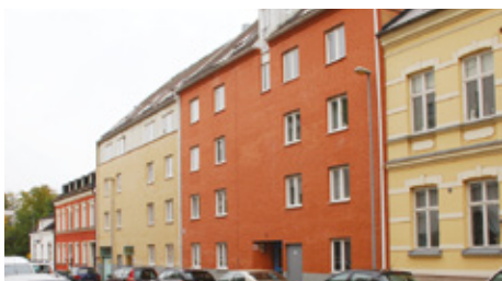
Ny frånluftsvärmepump har installerats på Västra Kyrkogatan 5-7.
